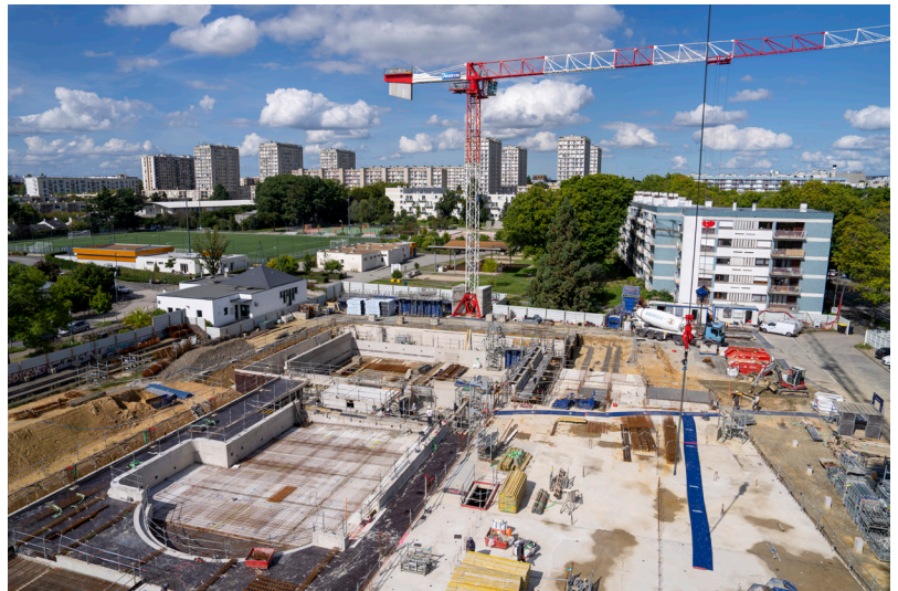
Septembre 2024, chantier de la nouvelle piscine de Villejean © Arnaud Loubry
