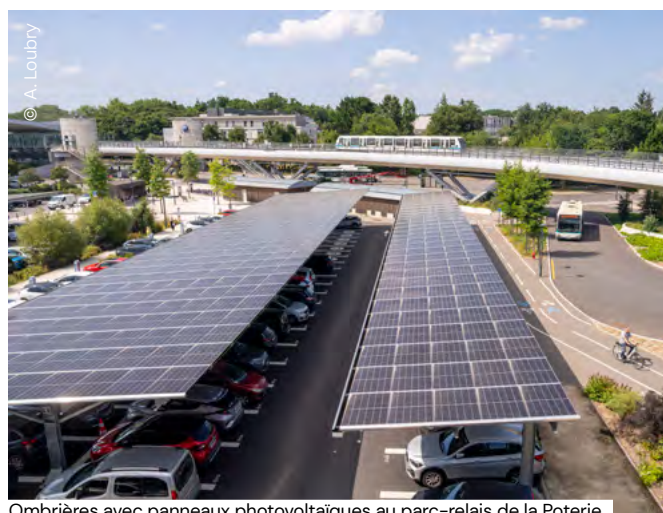
Ombrières avec panneaux photovoltaïques au parc-relais de la Poterie.
