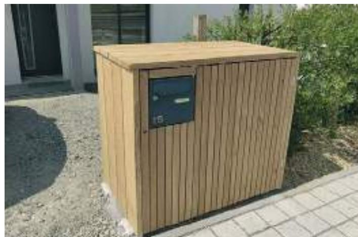
Exemple d'intégration de la boîte aux lettres et du coffret électrique dans un muret technique avec habillage bois
