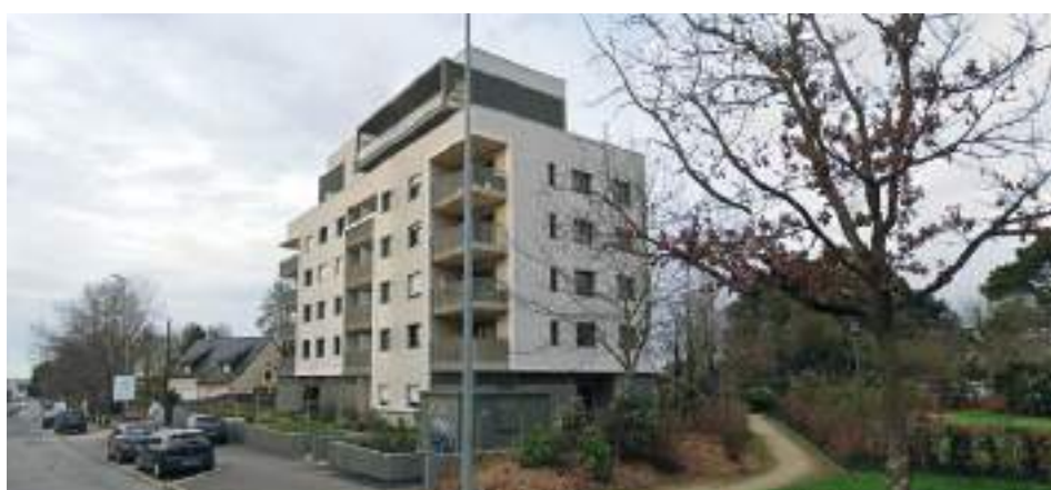
Vue du bâtiment Icade depuis la rue de Châteaugiron (Sud)
