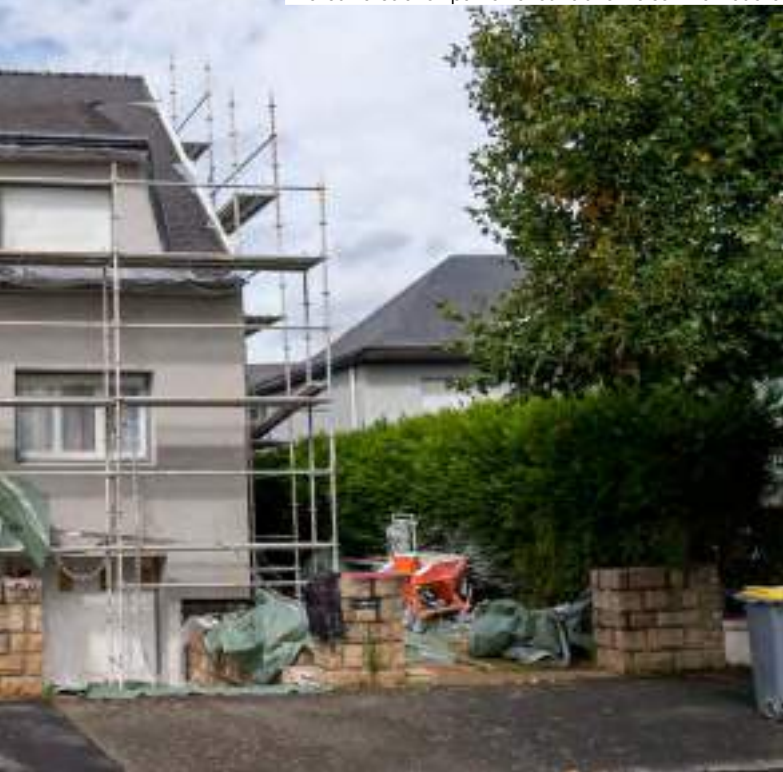
Travaux d'isolation par l'extérieur d'une maison individuelle.
