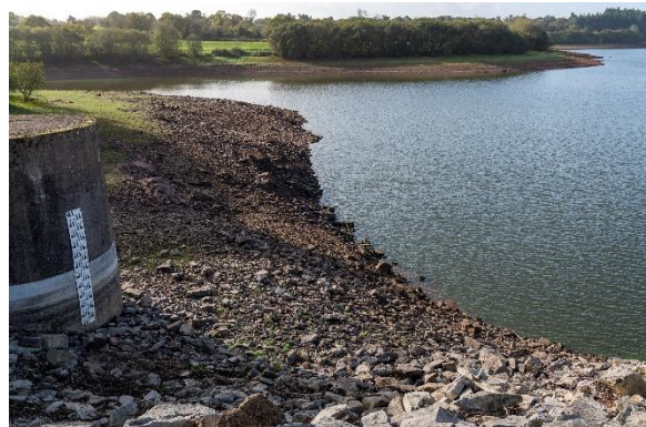
BARRAGE DE LA CHÈZE EN 2022
